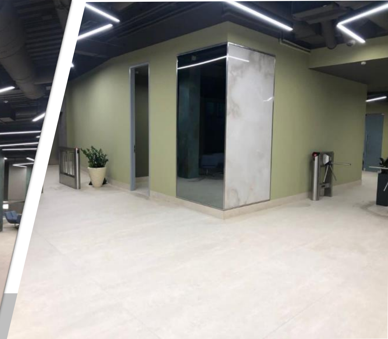
Реконструкция МОПов Генеральный подрядчик 1 100 м 2
